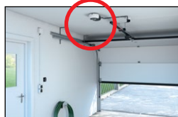
I taket, inntil motorskinnen
